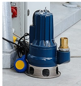
Tauchpumpe und Schwimmer für den automatischen Zulauf des ablaufenden Wassers in den Dekanter
